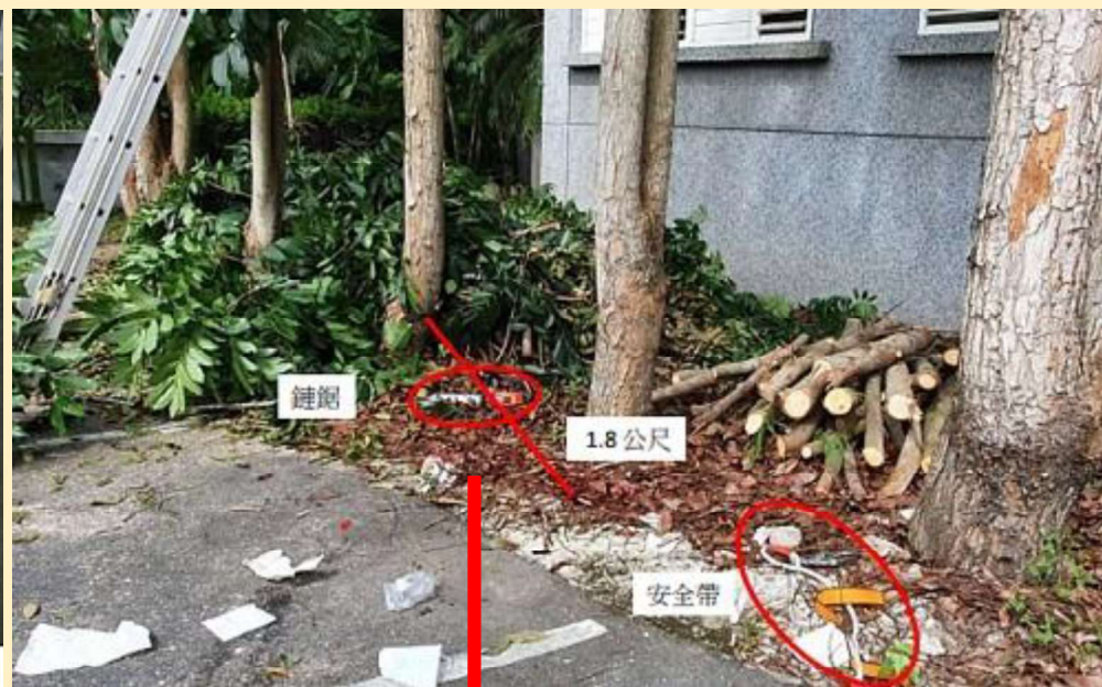
現場遺留鋸樹用鏈鋸及急救時從罹災者身上脫下之安全帶；罹災者後腦著地留下血跡與樹底距離約1.8公尺。
