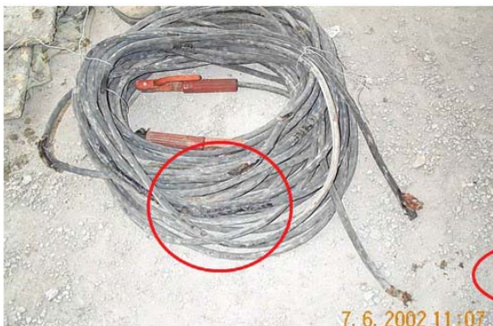
絕緣破損之電焊接用線
