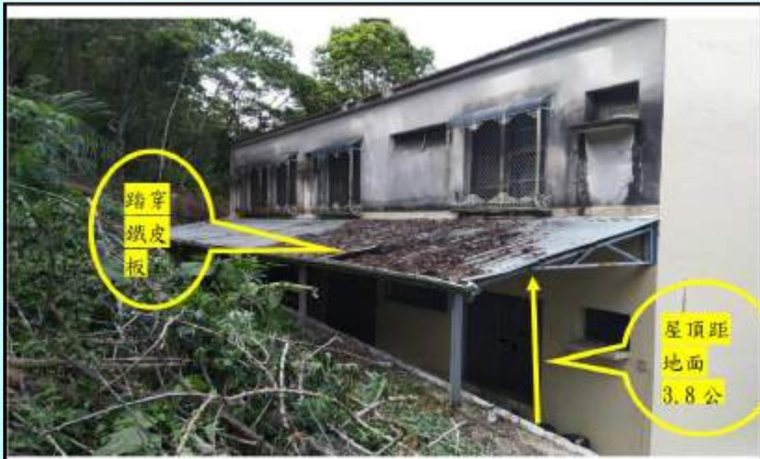
照片 1 屋頂（未設置護欄未設置安全母索及未設寬 30 公分以上踏板）踏穿鐵皮板
